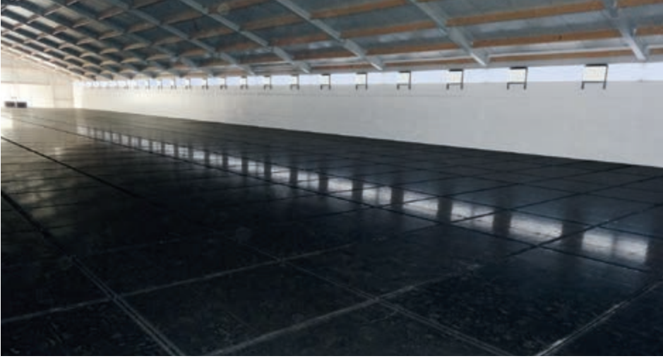
Sistem ikinci seviyeye monte edilmeden önce plastik levhalardan yapılmış bir ara tavanın görünümü
