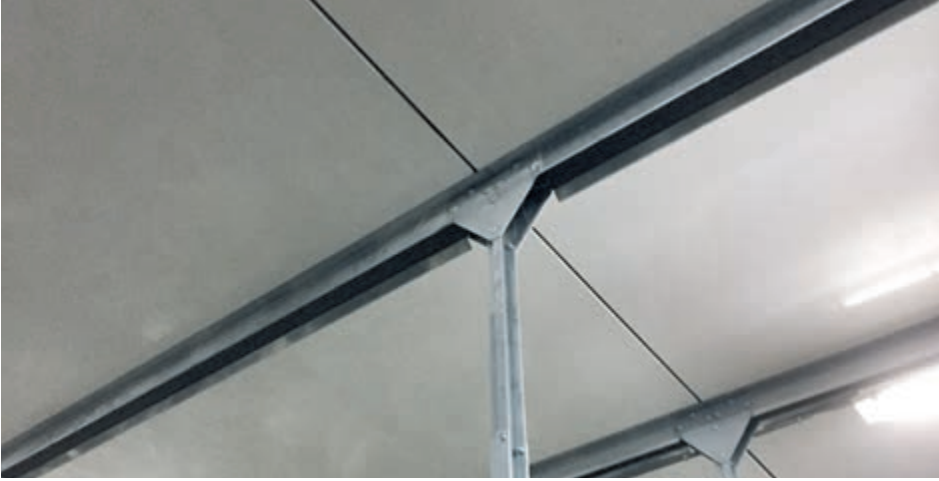
Plastik panellerin pürüzsüz, beyaz yüzeyi, temiz havanın kümes içinde engel olmadan çapraz akmasını sağlar ve ayrıca alt seviyedeki parlaklığı artırır
